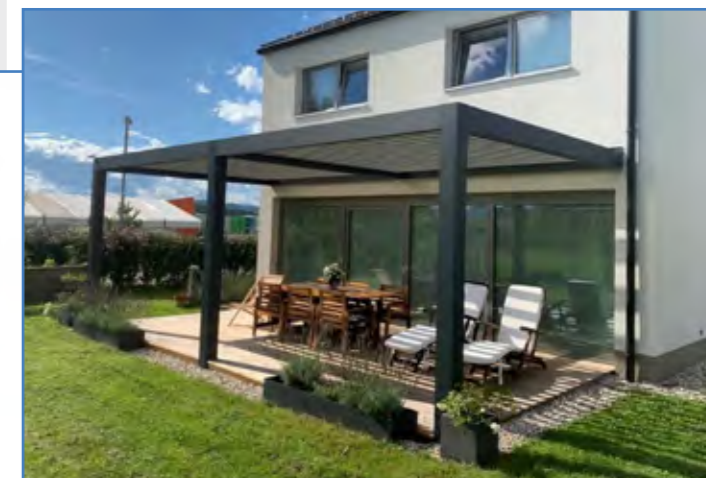
MJEŠOVITA IZVEDBA (stupovi i zidno sidrenje)
